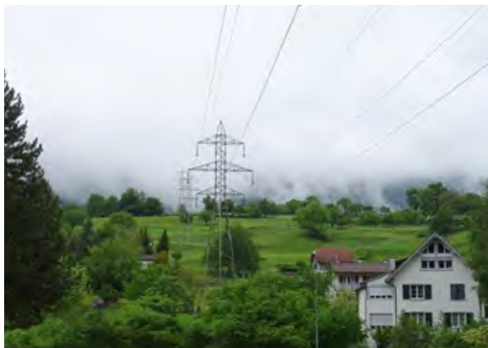
Durch den Rückbau der bestehenden Leitung werden Ortschaften wie Herbetswil spürbar entlastet.
